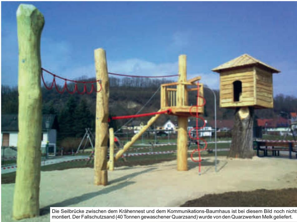
Die Seilbrücke zwischen dem Krähennest und dem Kommunikations-Baumhaus ist bei diesem Bild noch nicht montiert. Der Fallschutzsand (40 Tonnen gewaschener Quarzsand) wurde von den Quarzwerken Melk geliefert.
