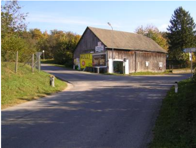
Kreuzung vor dem Umbau ohne Gehsteige und Bushaltestelle in der Kreuzung
