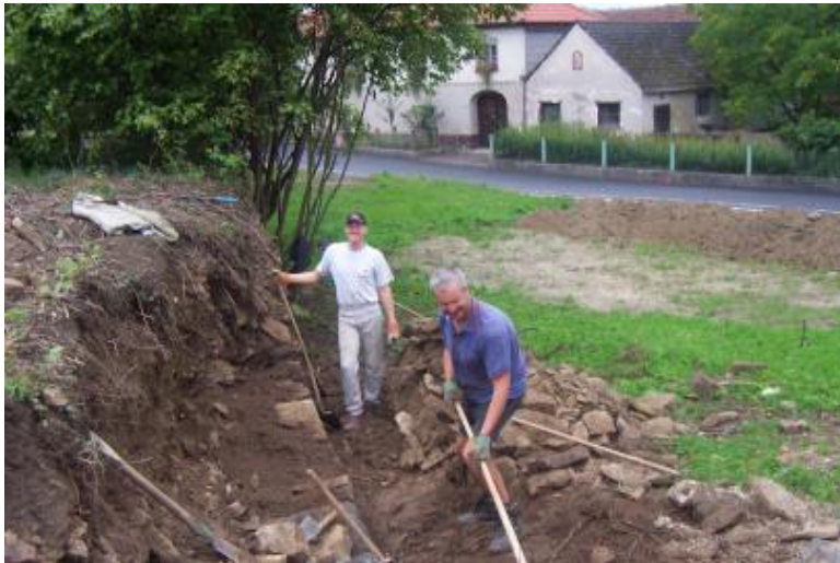
Sanierung der Trockensteinmauer, welche erhalten wurde!
