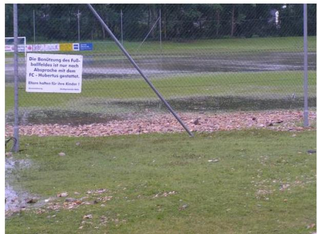
Die Spandrähte bei der Umzäunung mussten entfernt werden um einen optimalen Wasserdurchfluss zu ermöglichen.
