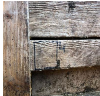
Abbildung 9: Probestelle 4 (Holz) im Warteraum
